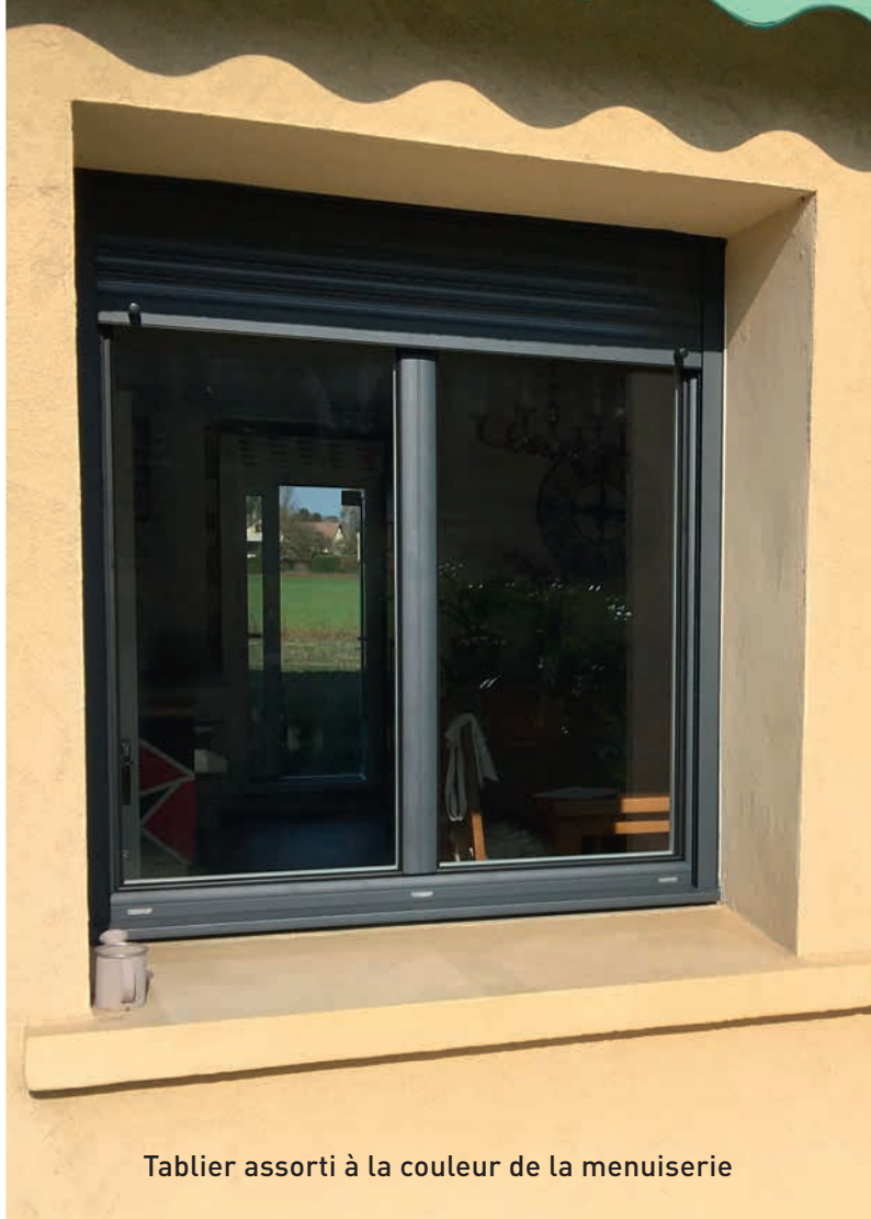
Coffre linteau : invisible placé sous le linteau dans le mur
