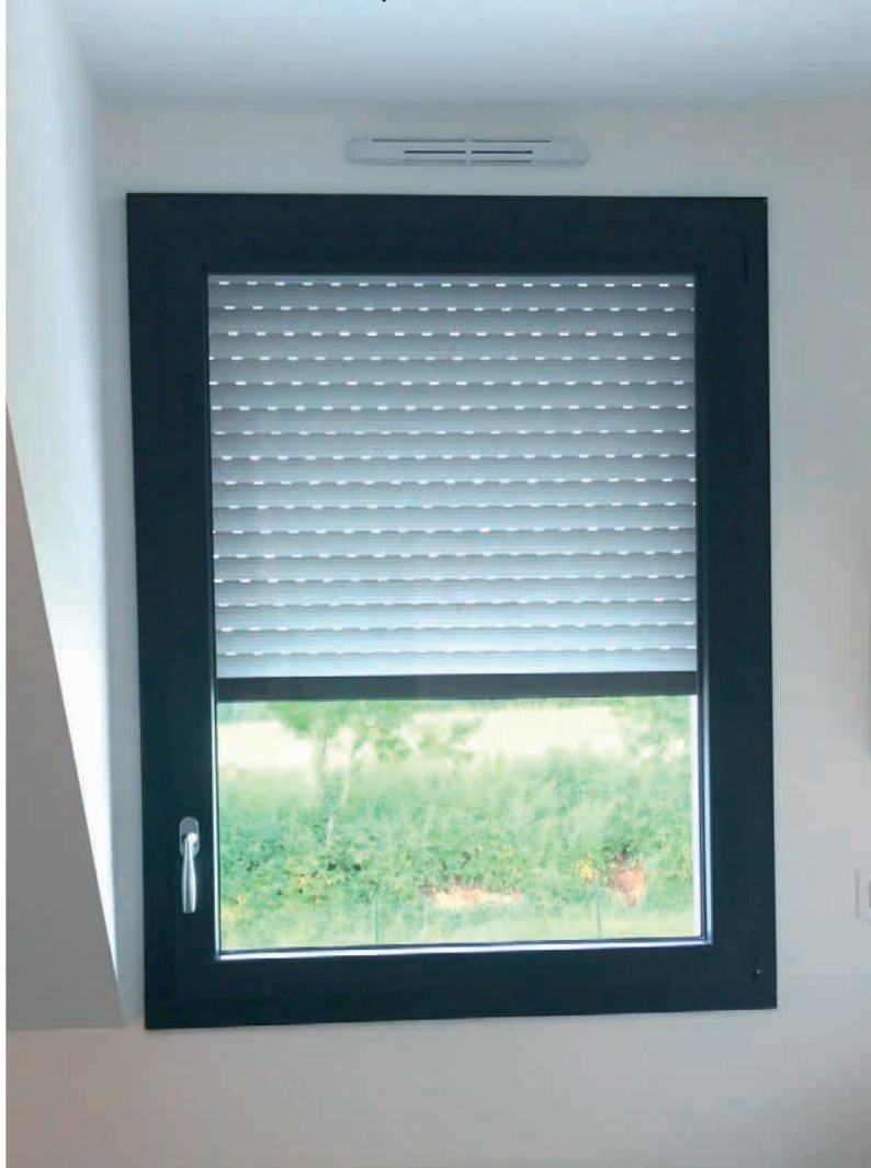
Coffre linteau : invisible placé sous le linteau dans le mur
